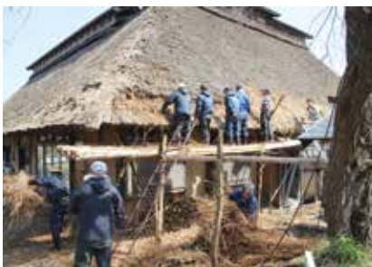
茅葺き屋根の補修作業
